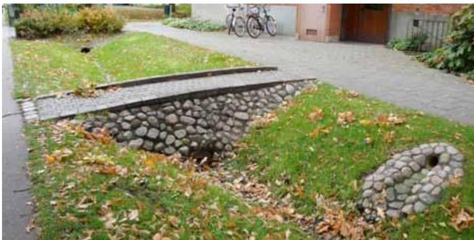
Figur 21. Fördröjningsmagasin som är utformat som svackdike. Gångbroar kan fungera som barriär för skiljning mellan trappstegsmagasins olika sektioner. (Källa: Dagvattengruppen Sweco).
