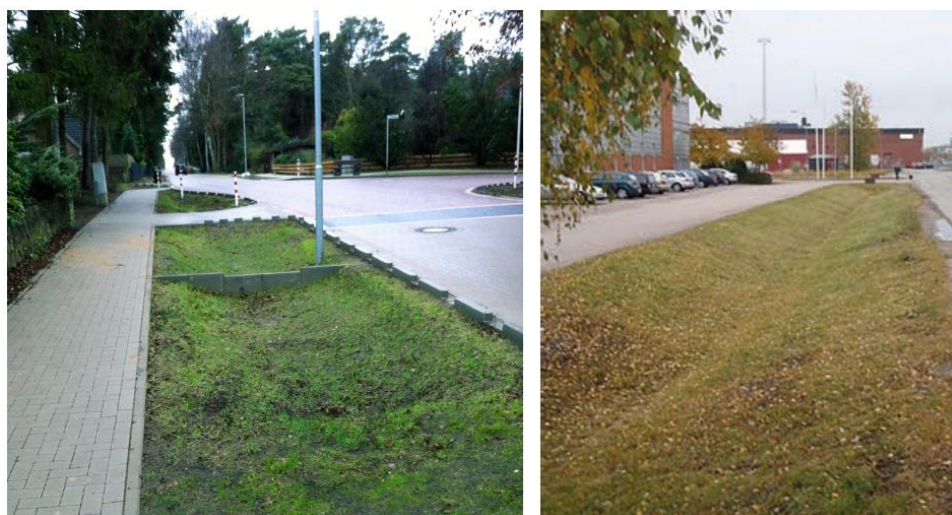
Figur 28. Två exempel på infiltrationsstråk (SVOA). Västra bilden visar ett sektionerat dike/infiltrationsstråk.
