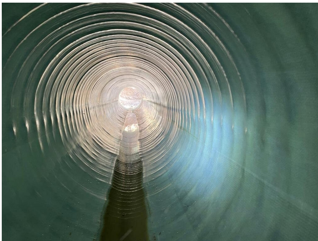
Figur 1, Renoverad dagvattenledning, Nora torg Fotograf: Simon Åkerlund
