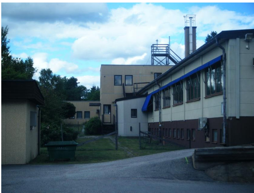
Figur 28. Industribyggnaden på Bromsen 11 innan ny exploatering.
