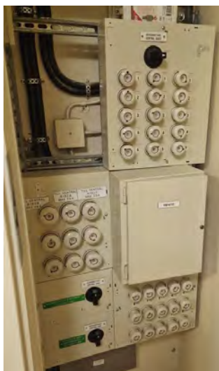
Befintliga elcentraler i elnisch skyddsrum.
