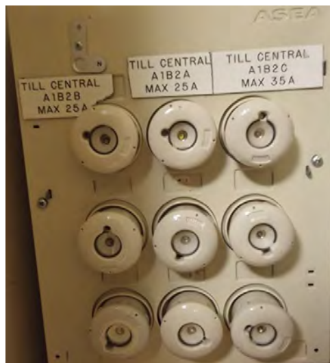
Befintliga elcentraler i elnisch skyddsrum.
