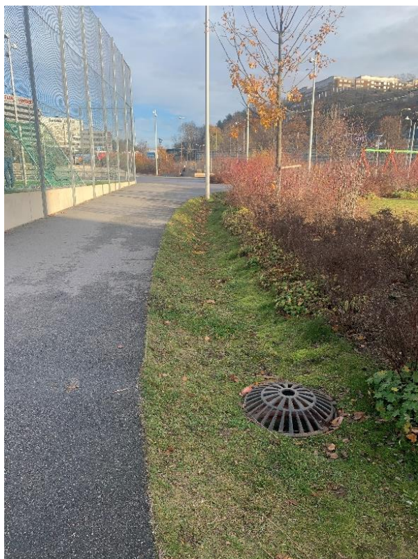
Figur 19. Infiltrationsstråk har en god förmåga att rena dagvatten. Infiltrationsstråken förses ofta med en brunn som placeras över stråkets botten. Exempelbilder från Stockholm och Hammarby sjöstad. (Foto: Bjerking).
