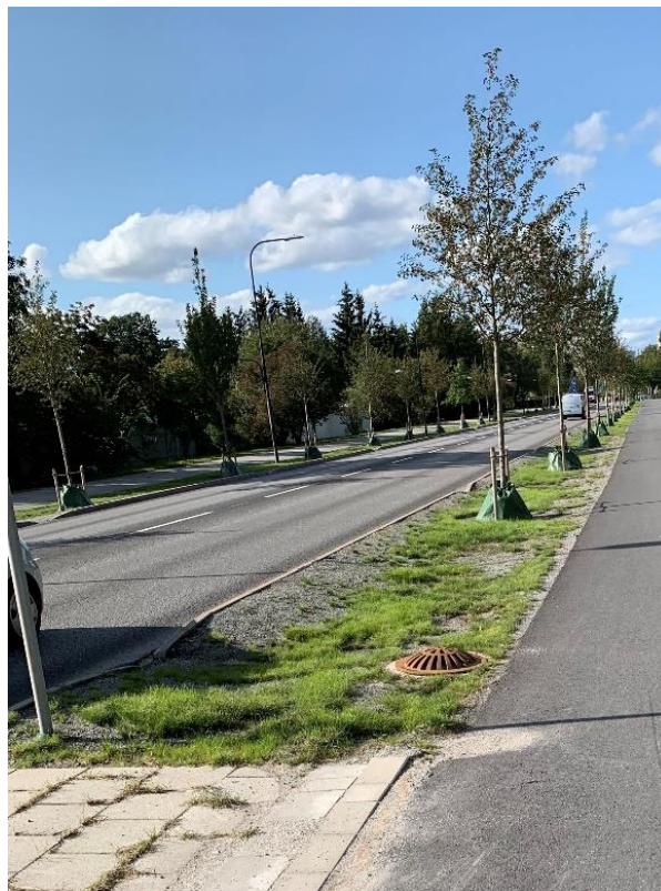
Figur 19. Infiltrationsstråk har en god förmåga att rena dagvatten. Infiltrationsstråken förses ofta med en brunn som placeras över stråkets botten. Exempelbilder från Stockholm och Hammarby sjöstad. (Foto: Bjerking).
