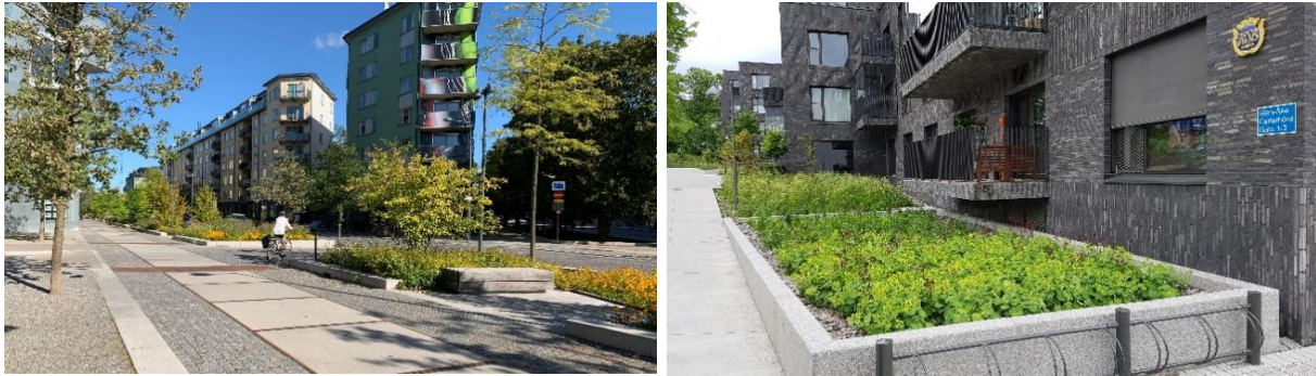
Figur 3. Exempel på lokala dagvattenlösningar med växtbäddar på allmän platsmark och på kvartersmark i Norra Djurgårdsstaden och i Göteborg (Foto: Bjerking).
