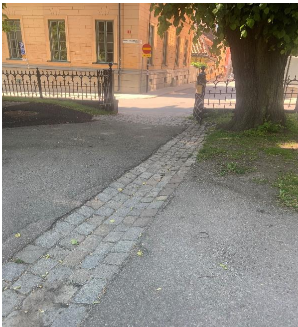
Figur 25. Exempelbilder på stuprörsutkastare och ränn dalar från Stockholm och Malmö. (Foto: Bjerking).
