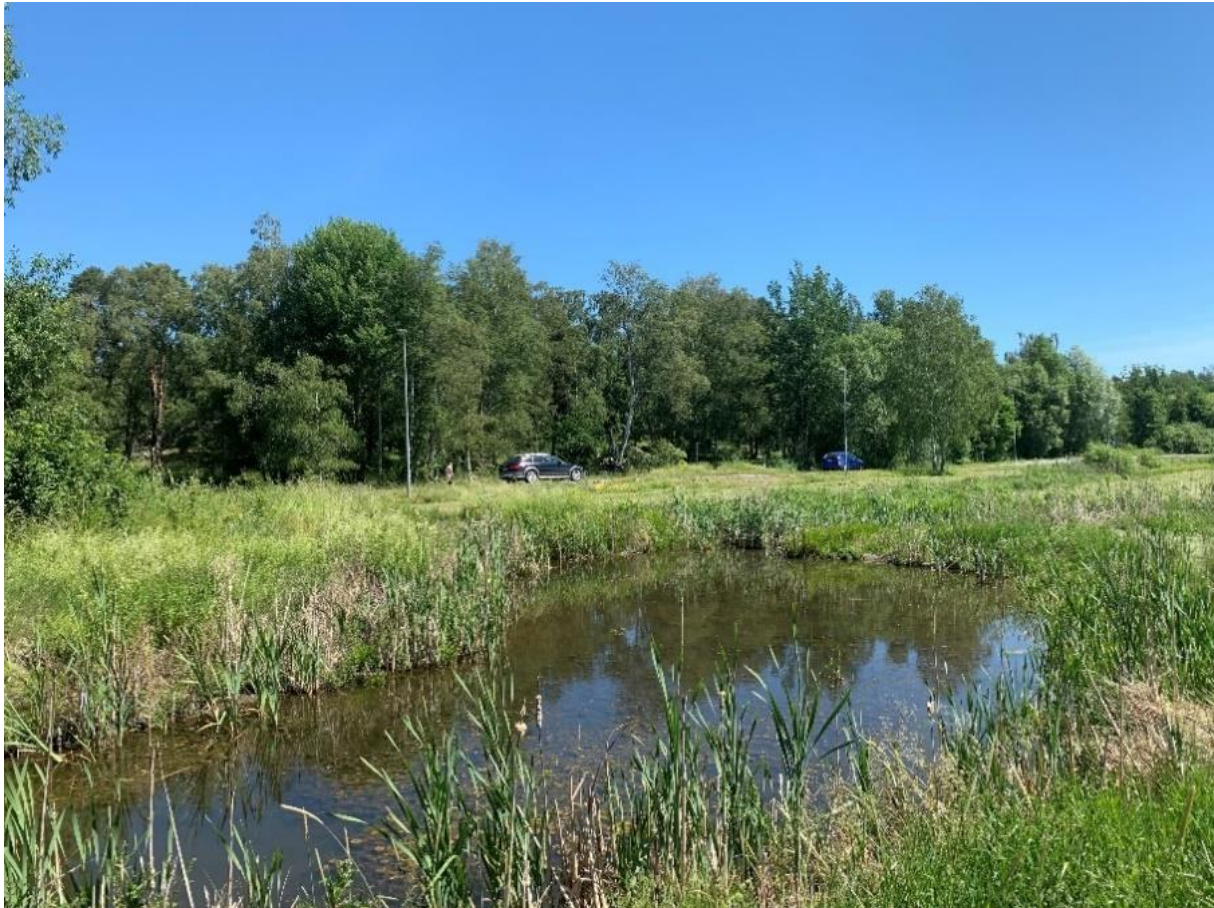
Figur 5. Dagvatten kan omhändertas i större nedströms dagvattenlösningar som dammar. Foto från Angantyrdammen i Danderyd. (Foto: Bjerking).
