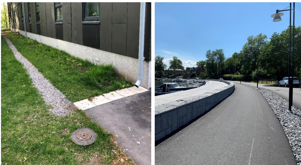
Figur 21. Makadamdiken kan anläggas både på kvartersmark samt allmän platsmark. T.V. visas fördröjning av takvatten från ett flerbiljshus i Stockholm (Foto: Bjerking). T.H. är ett makadamdike mellan väg och gång- och cykelbana i Samsjövik i Danderyds östra delar (Foto: Danderyds kommun).
