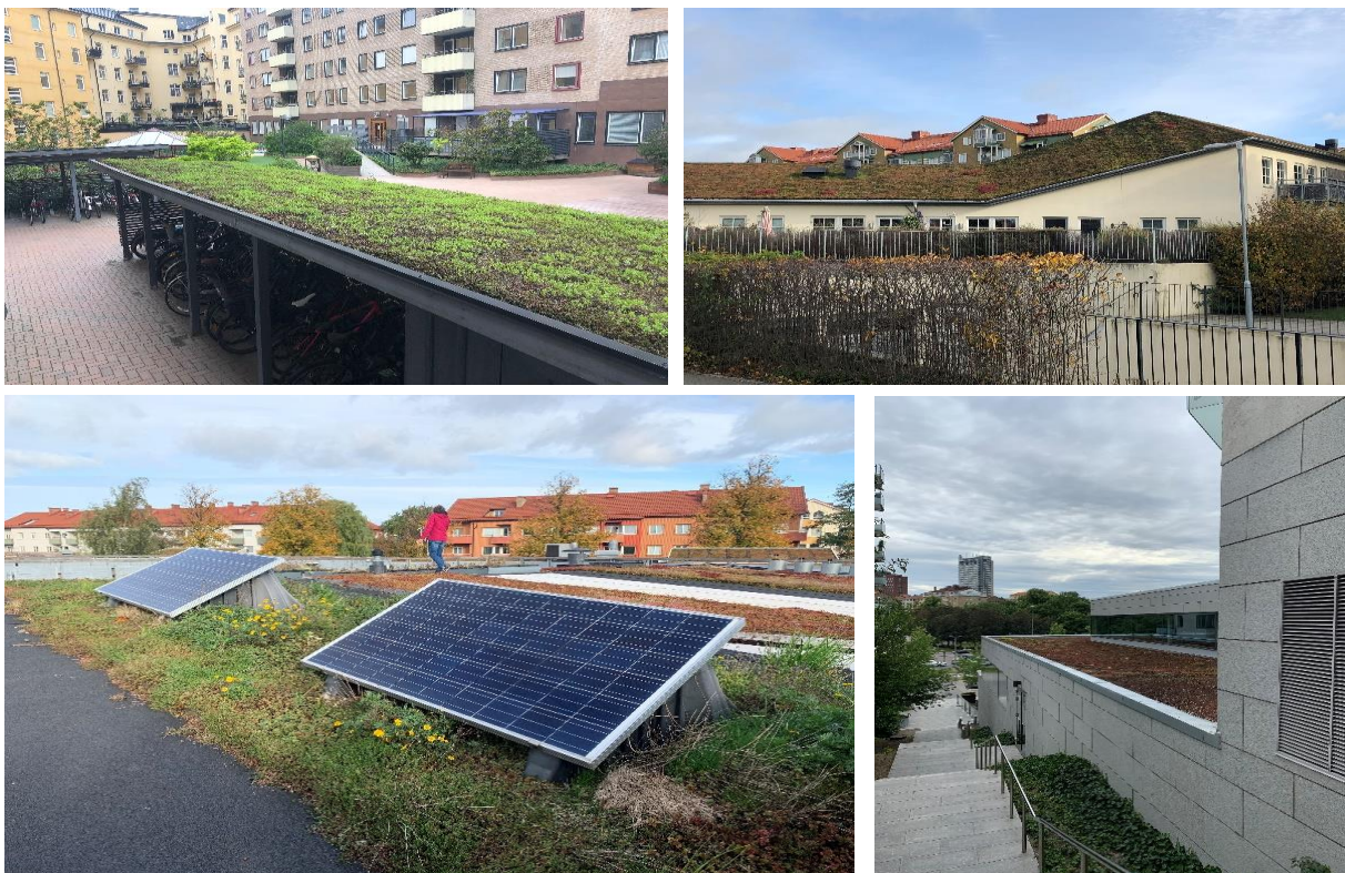
Figur 22. Vegetationsklädda tak, eller så kallade gröna tak, kan anläggas på hustak och komplementbyggnader så som exempelvis sophus och taklagda cykelställ. Exempelbilder från Stockholm och Malmö (Foton: Bjerking)
