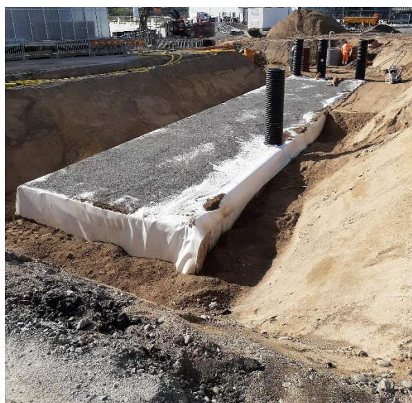
Figur 29. Underjordiska magasin som detta kassetmagasin i Järfalla (uppe) och Sollentuna (nere) kan användas i områden där ytor för anläggningar i marknivå saknas. (Foto: Bjerking).
