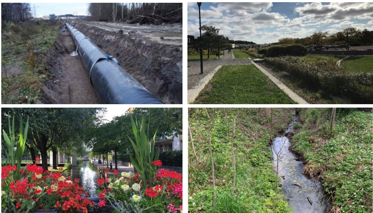
Figur 4. Avledning av dagvatten kan ske via ledningsnät, diken och öppna blå-gröna dagvattenstråk (Foto: Bjerking).
