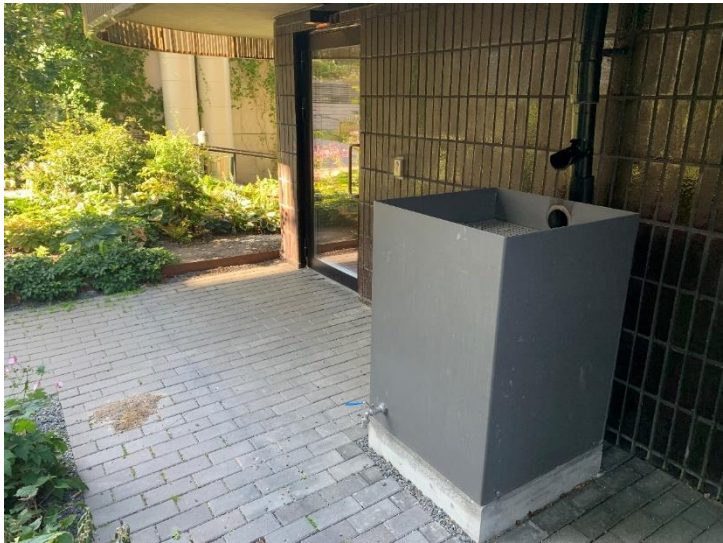
Figur 27. Regnvattentunna som utformats med tappkran kan användas för bevattning på kvartersmark i Norra Djurgårdsstaden. (Foto: Bjerking).
