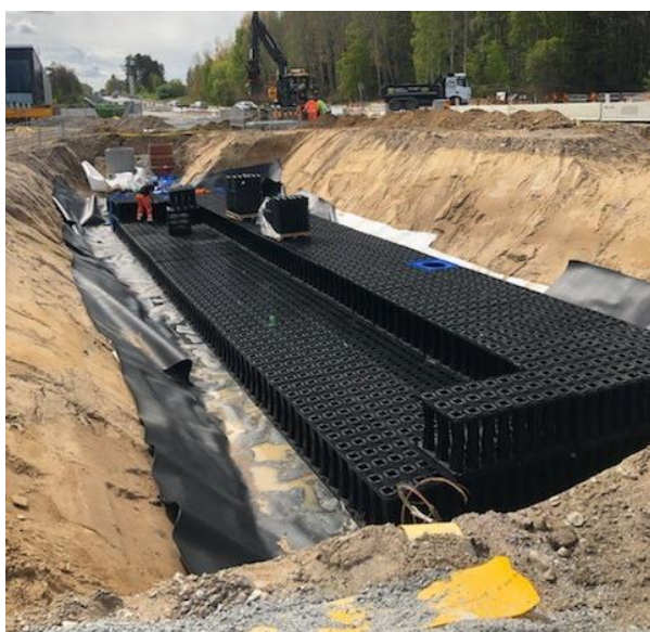
Figur 29. Underjordiska magasin som detta kassetmagasin i Järfalla (uppe) och Sollentuna (nere) kan användas i områden där ytor för anläggningar i marknivå saknas. (Foto: Bjerking).
