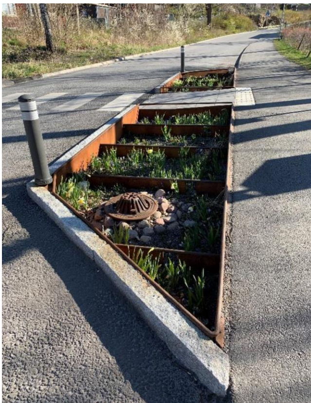
Figur 10A. Nedsänkt växtbädd i anslutning till lokalgata eller parkering, Bjerking/Danderyds kommun 2021
