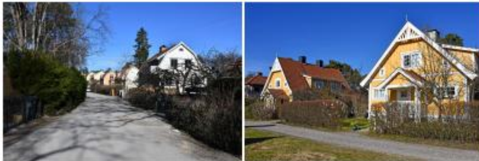
Mindre villor av egnahemskaraktär, byggda för en lägre samhällsklass. Till höger arbetarbostäder i kv. Vale.
