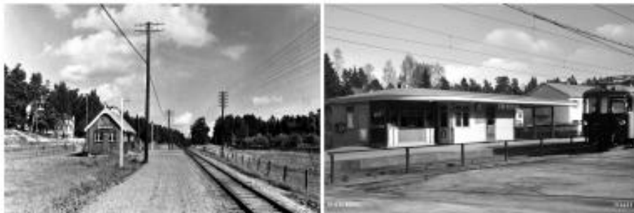
Enebybergs hållplats i två olika skepnader. Källa: Järnvägsmuseet
