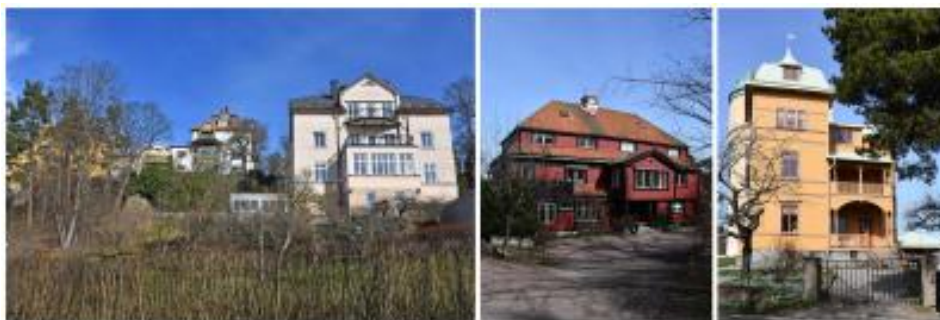
Exempel på högborgerlig bebyggelse i delar av Stocksund som bebyggdes runt sekelskiftet 1800/1900.
