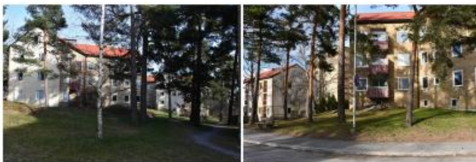
Flerbostadshus vid August Wahlströms väg / Axel Johnsons väg i Danderyd.
