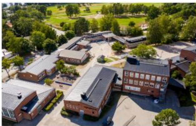
Kevingskolan med sina tidstypiska byggnadskroppar i tegel.
