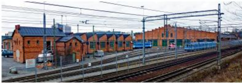
Mörby verkstäder intill Roslagsbanan. Den stora byggnaden med trappstegsgavel är vagnhall.
