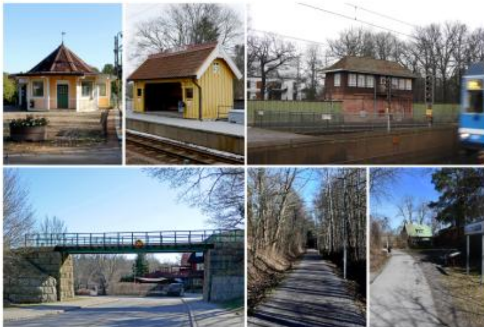
Ovan: Väntkur vid Vendevägen, Djursholms Ösby station med ställverket till höger. Nedan: Spårsträckningar efter Djursholmsbanan. Akvedukt över Ymervägen i Svalnäs.
