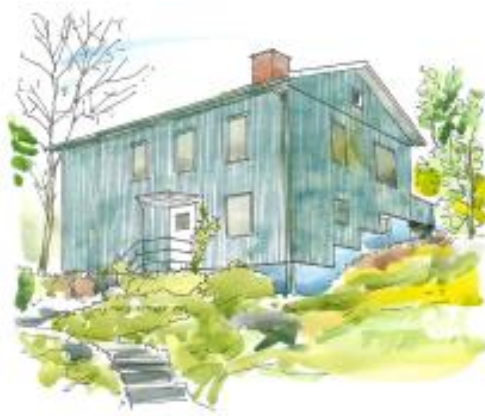
Typhus från 1940-talet av enklare karaktär med skärmtak och fönster utan spröjs.
