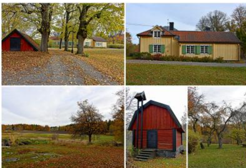
Berga gård med huvudbyggnad från sent 1700-tal. På gården finns flera välbevarade ekonomibygnader, bland annat ett magasin med vällingklocka. Gården omges av en fruktträdgård och odlingslandskap.
