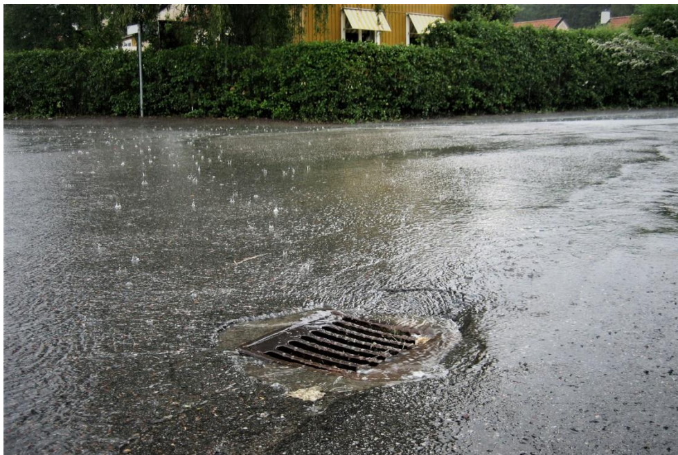
Bild ovan: Regnvatten i dagvattenbrunn.
