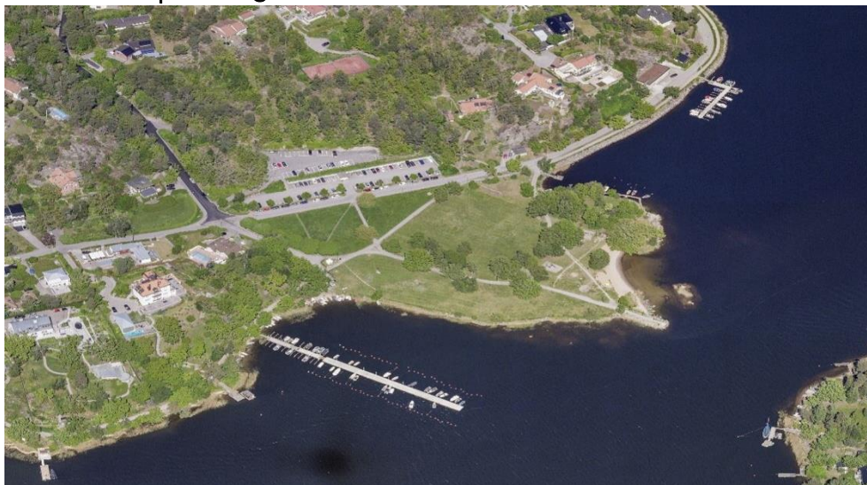
Bild ovan: Svanholmsparkeringen - Ortofoto från 2019.
