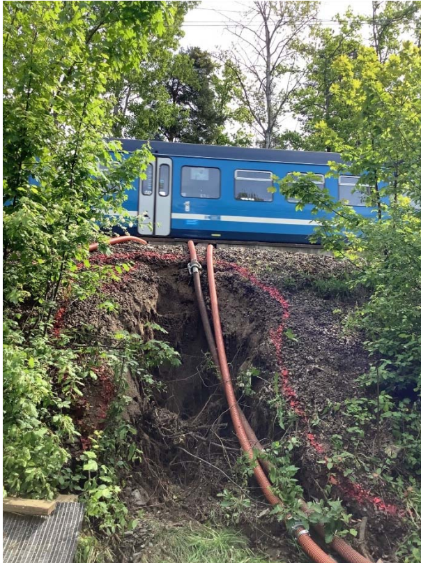
Figur 13, Underminering av räls Roslagsbanan efter ihållande regn maj 2021.
