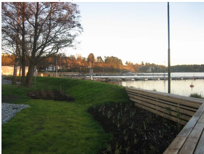
Figur 11 Översvämningsskydd vid Nora strand
