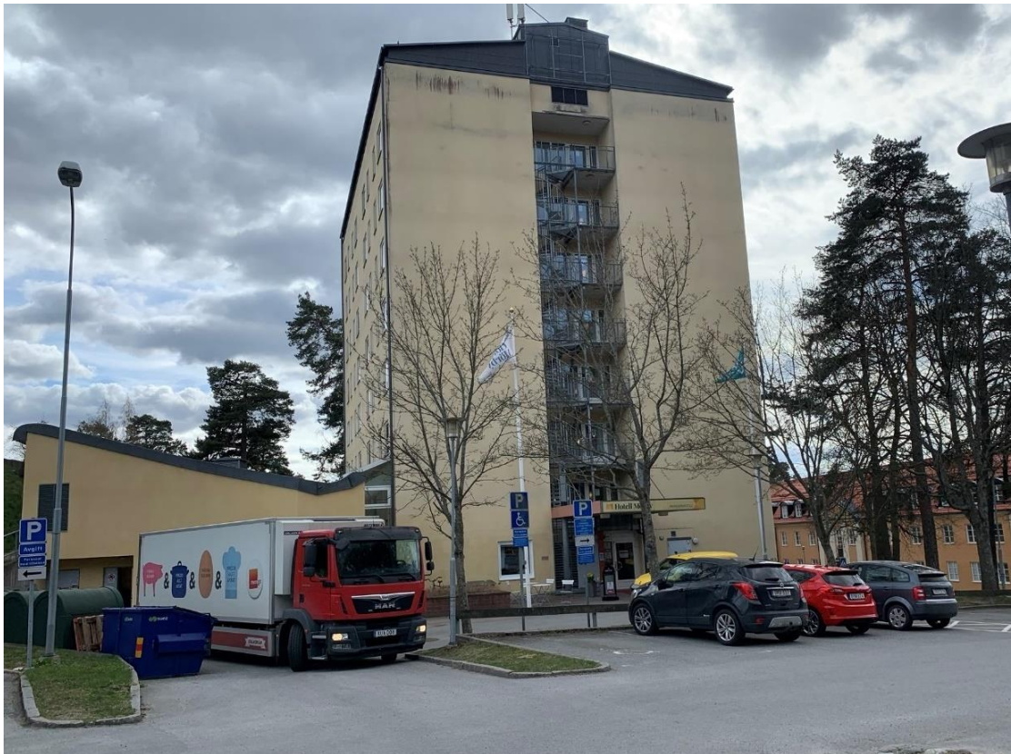
Vy från norr över patienthotellets norra fasad och angöringsytor.
