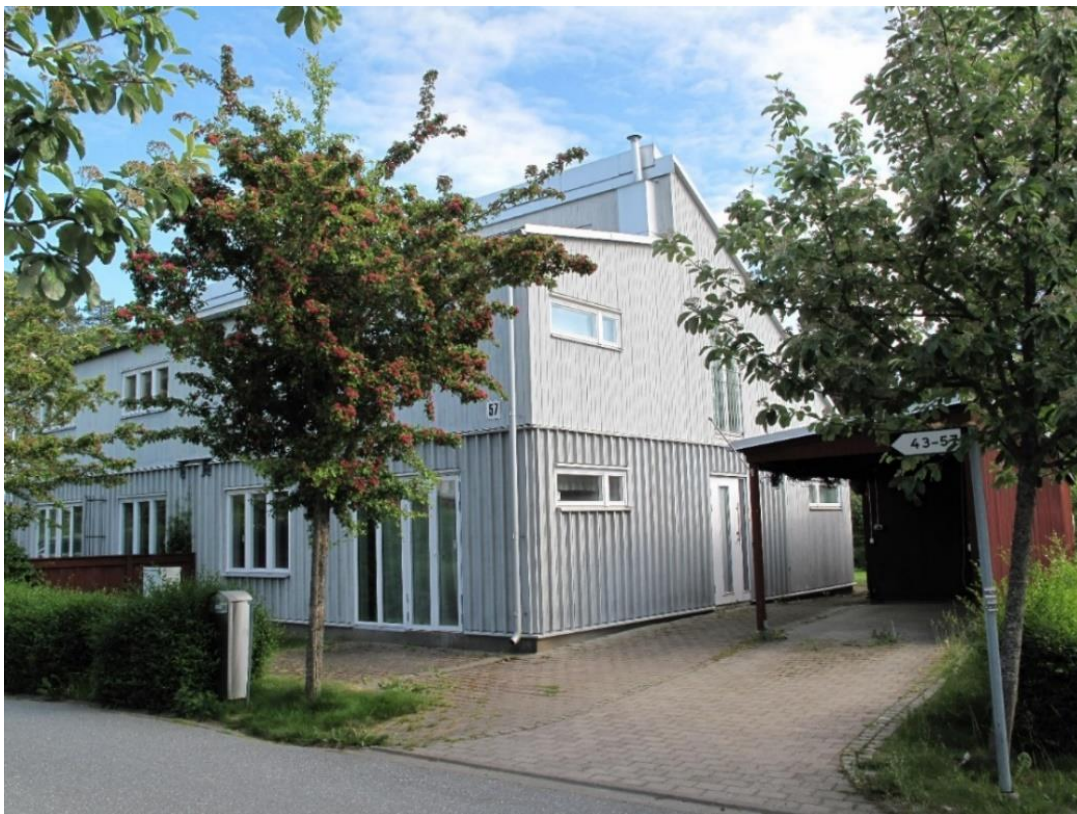
Parhus i grå träfasad och tillhörande carport och bilparkeringsplats på tomten sett från angörande gata.
