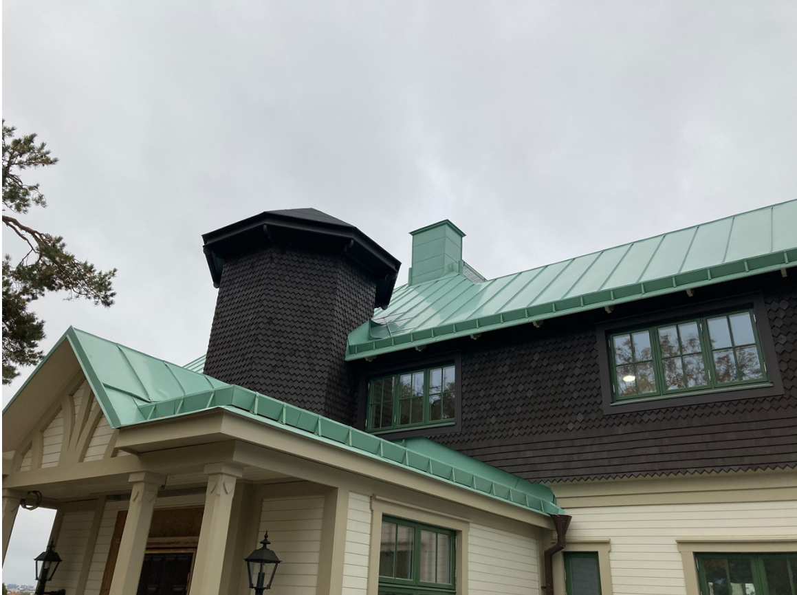
Figur 1: Byggnaden inom Byggmästaren 19 med torn del och entré.
