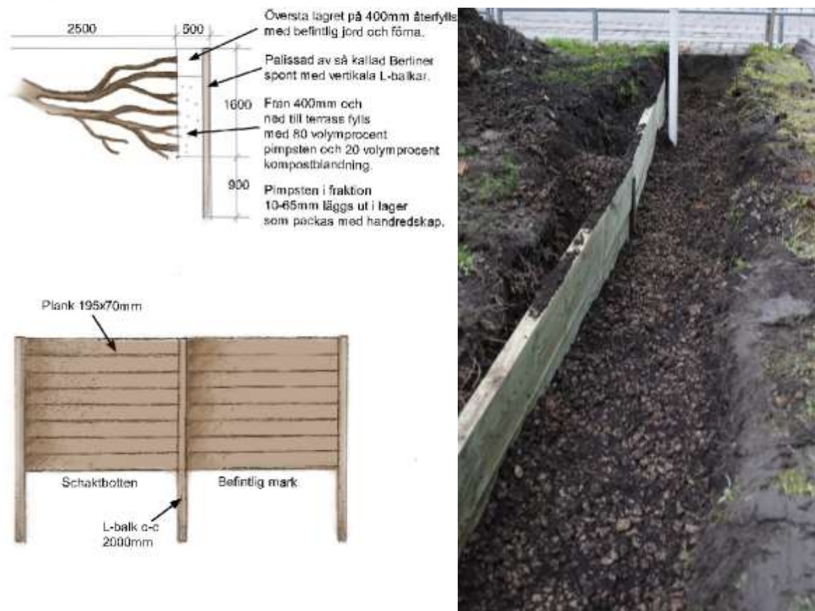
Bild 8. Skyddsspont med pimpstenssubstrat mot schaktvägg där rötter beskrivits.
