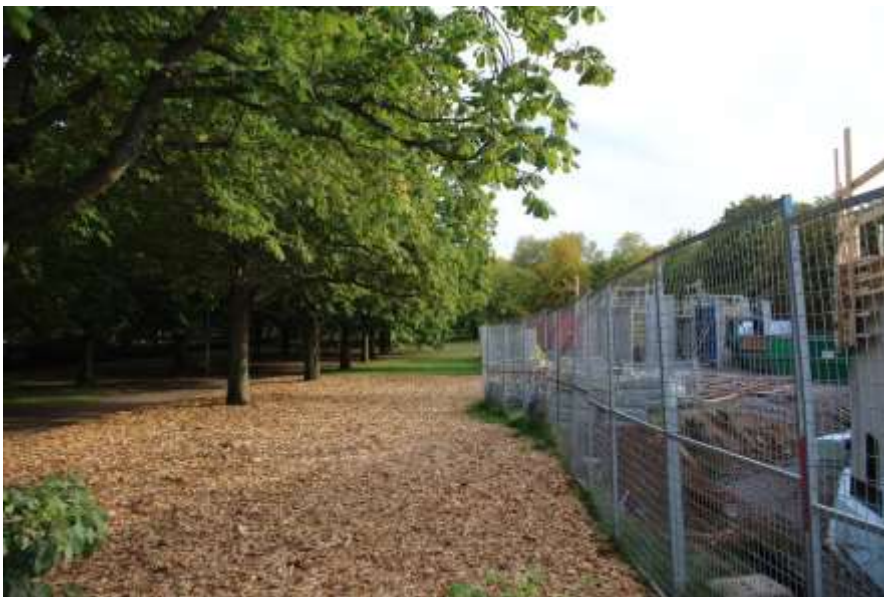
Bild 1. Skyddsstängsel och marktäckning (Mulching) som skydd vid intilliggande byggnation.
