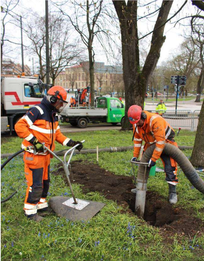
Bild 3. Skonsam schakt med tryckluft och vakuumsugning nära träd.
