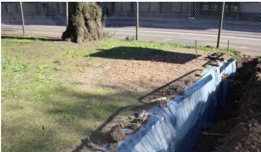
Bild 6. Rotdraperi av plast vid schaktvägg för att motverka uttorkning av jord och beskurna rötter.
