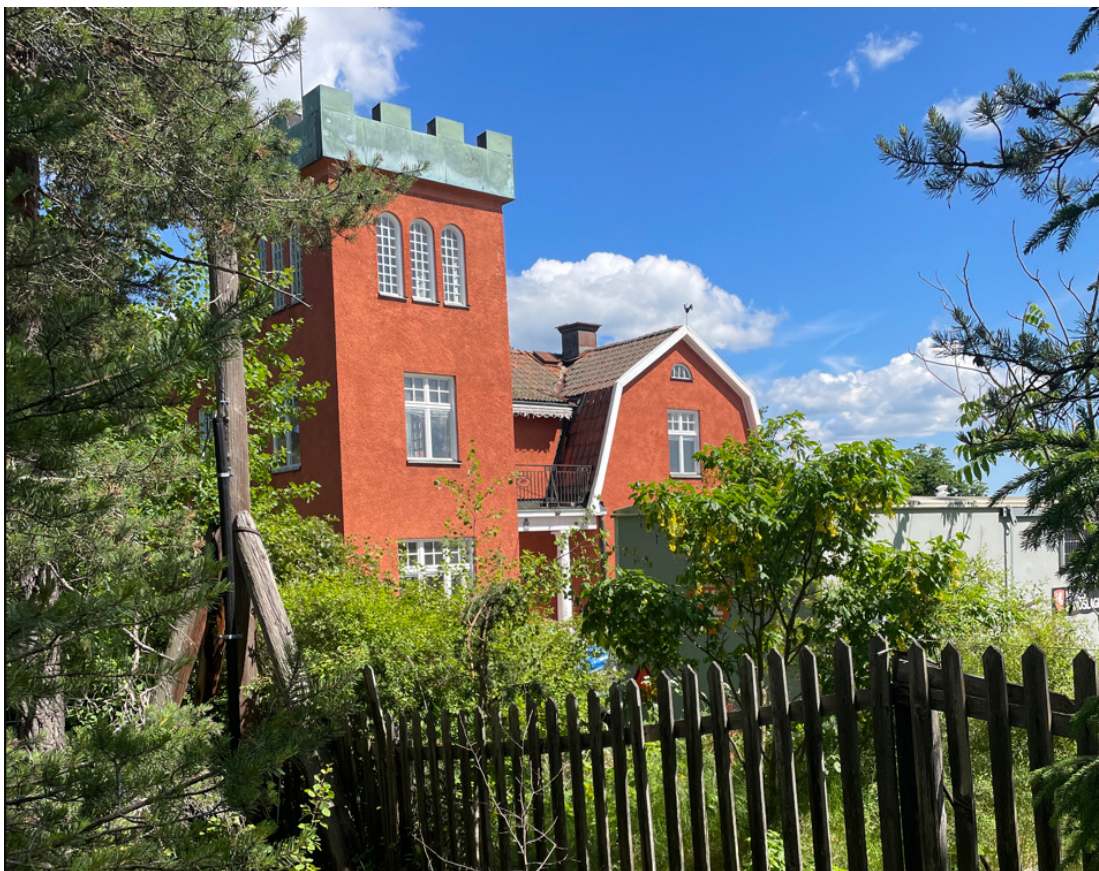
Befintlig huvudbyggnad inom Tärnan 3.
