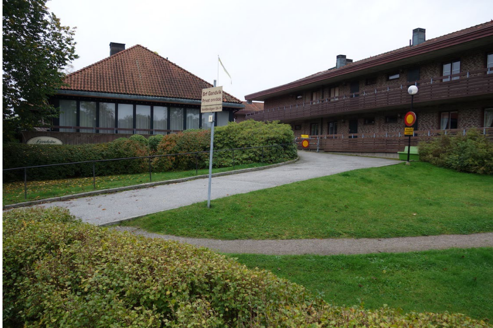
Gavelfasaden mot Djursholms torg hösten 2020.
