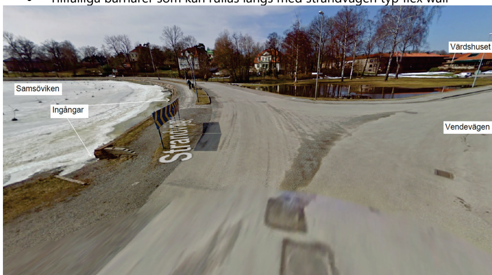
Bild 4 Mur kring strandvägen
