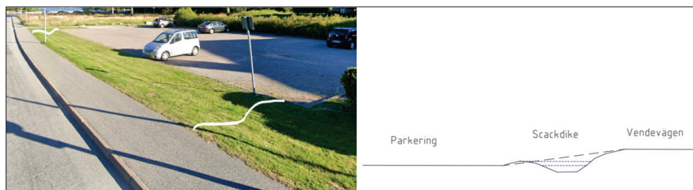
Bild 3 Svackdike längs befintlig parkering
