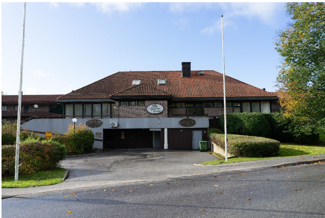
Figur 4. Befintlig vårdhusbyggnad från Vendevägen
