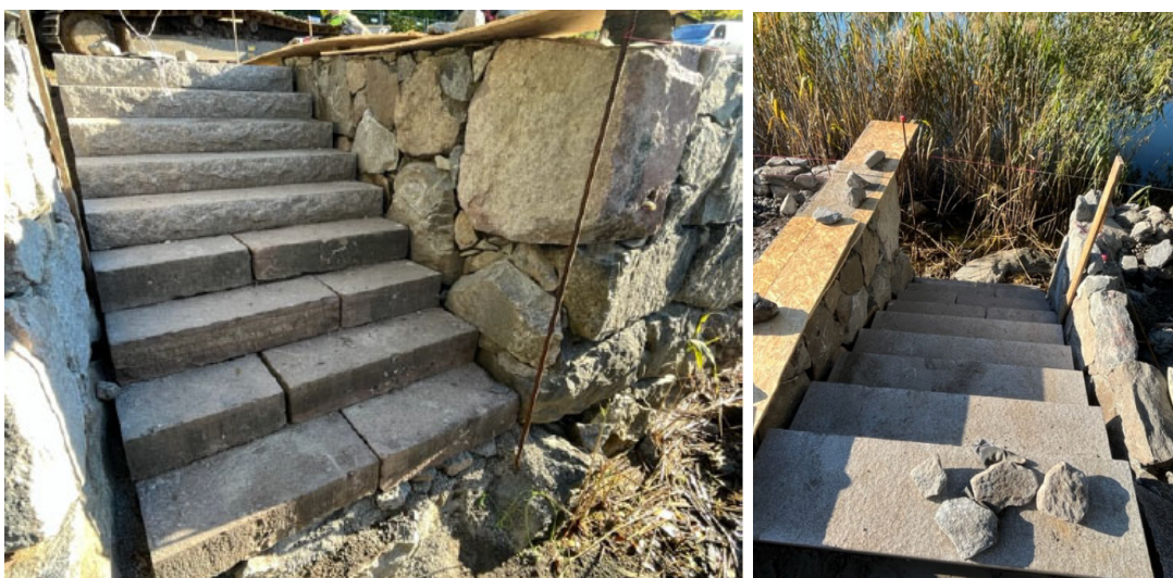
Foton från platsen då arbetet påbörjats med trappa i nytt läge, 2022-09-28
