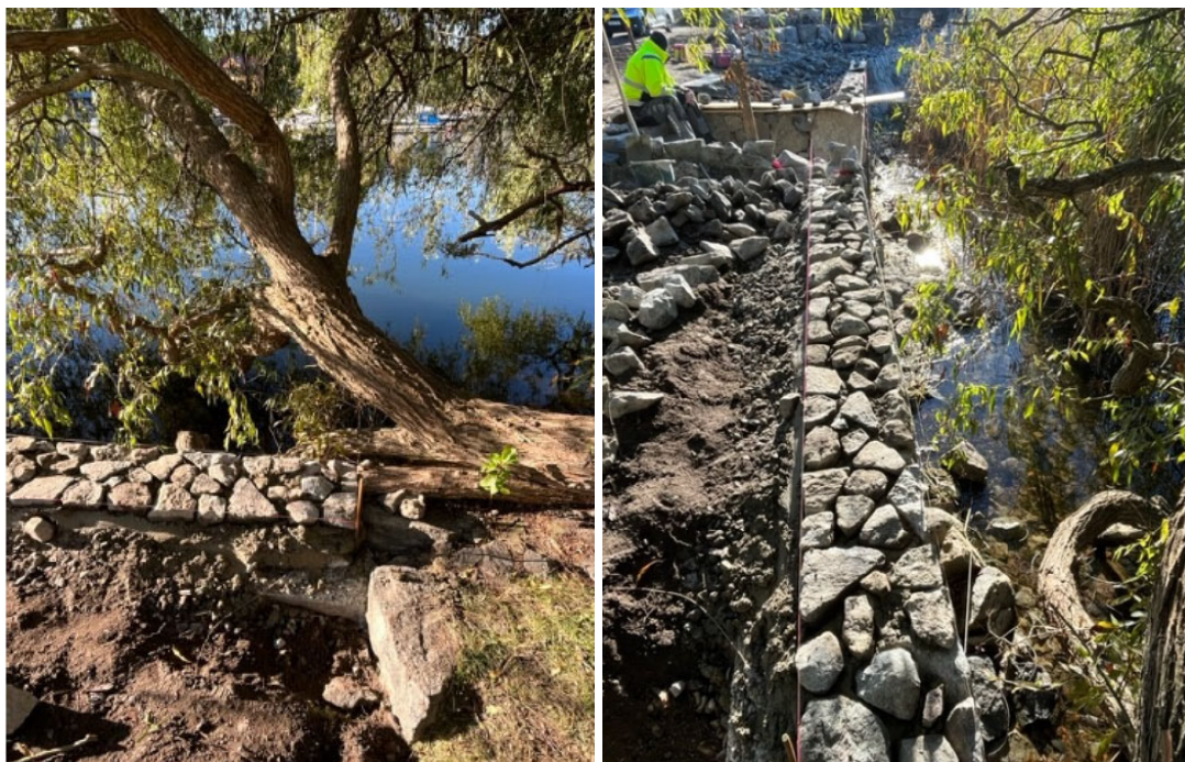
Foton från platsen då arbetet påbörjats, 2022-09-28
