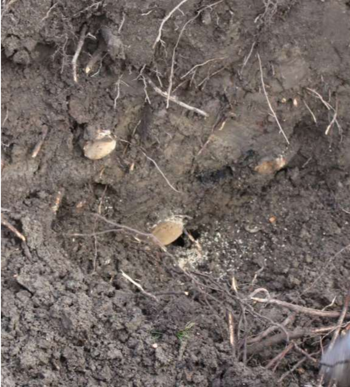
Bild 5. Korrekt beskurna rötter vid schakt.
