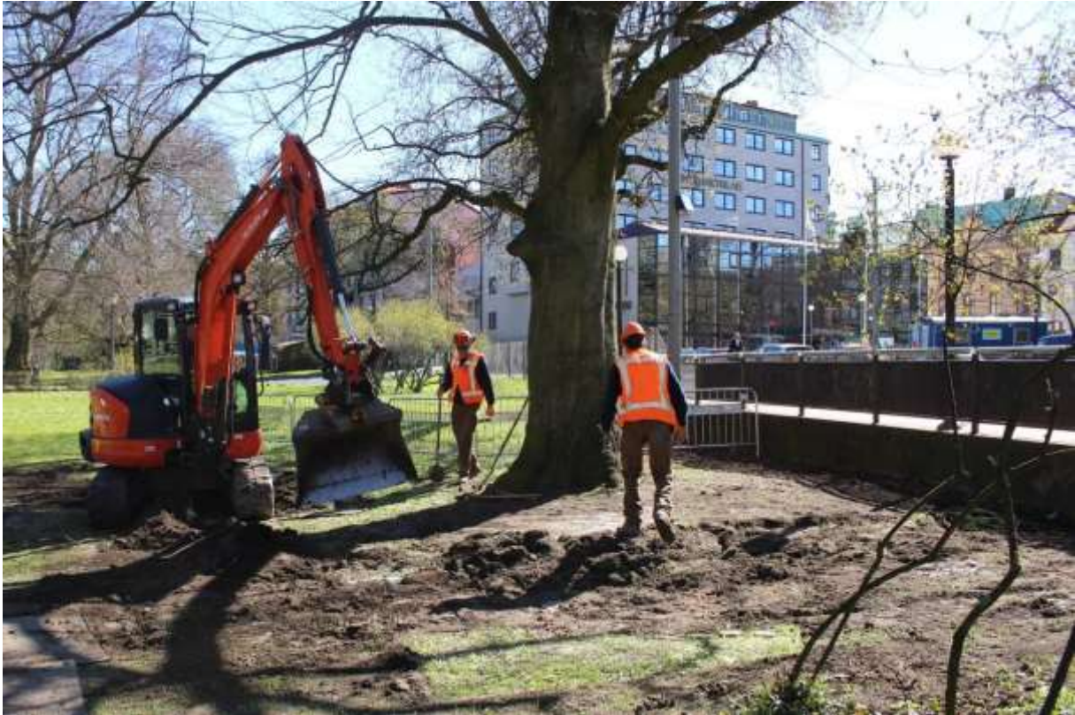
Bild 9. Avtagning av grässvål vid utförande av markvitalisering.
