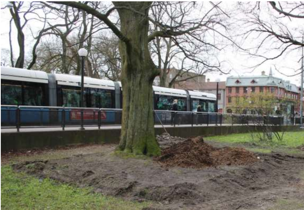
Bild 10. Utläggning av mulch på avbanad yta vid markvitalisering.
