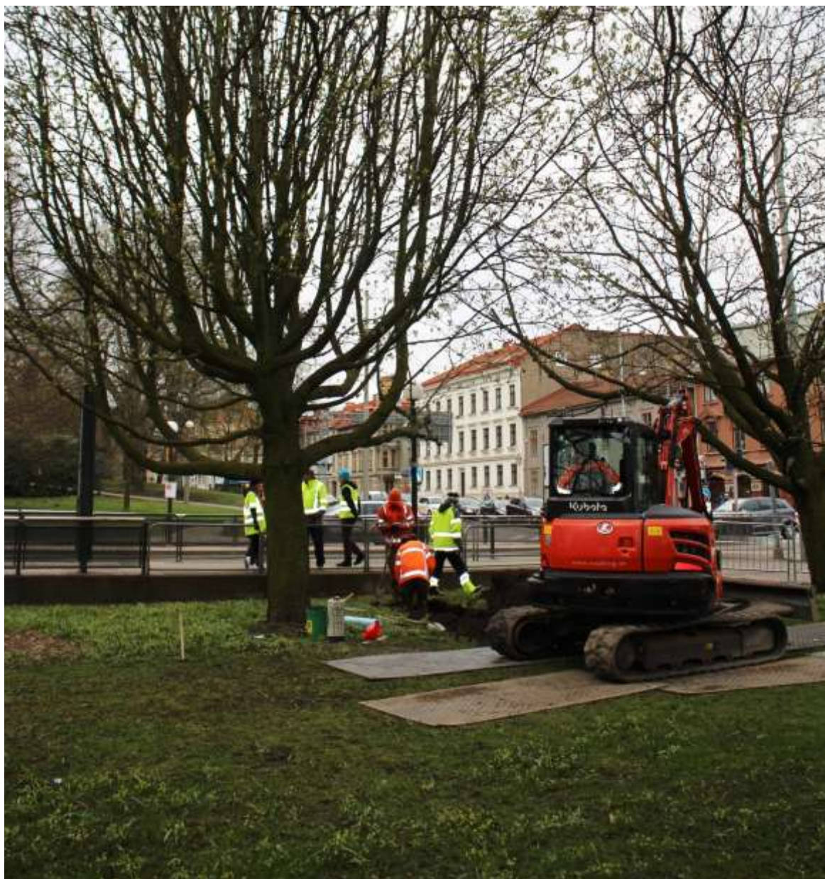
Bild 2. Markskydd av hårdplast används för att motverka markkompaktering vid grävning i parkyta nära träd.
