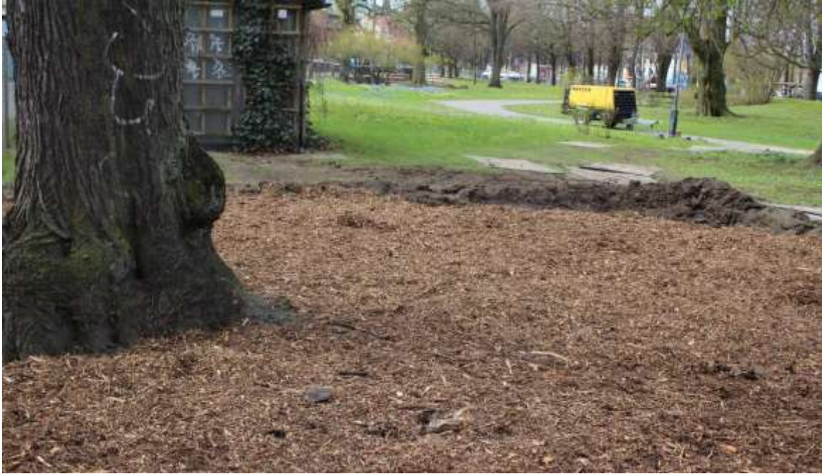
Bild 11. Färdigutlagt mulchlager vid markvitalisering.
