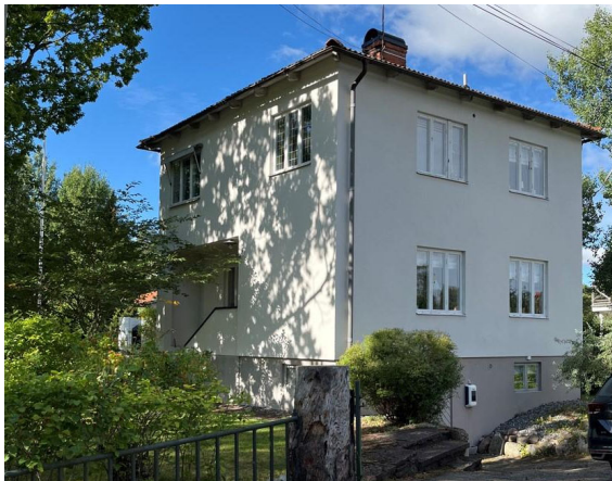
Foto på byggnaden tagen under byggnadsinventering inför framtagning av kulturmiljöprogram
