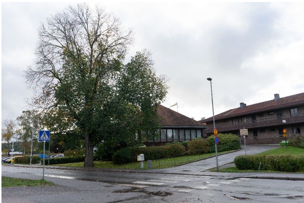
Figur 6. Befintlig byggnad från Henrik Palmes allé.
