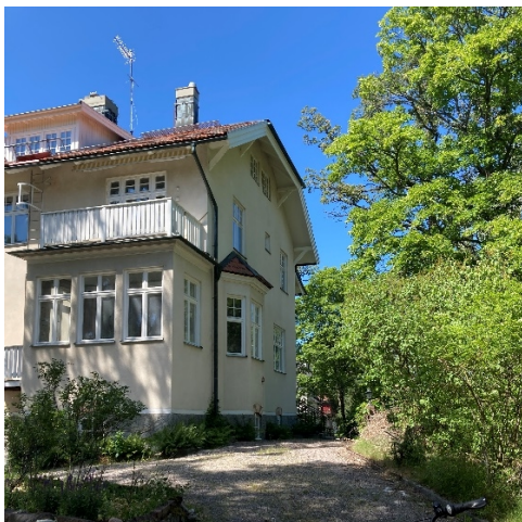
Byggnad sedd från Vikingavägen.
