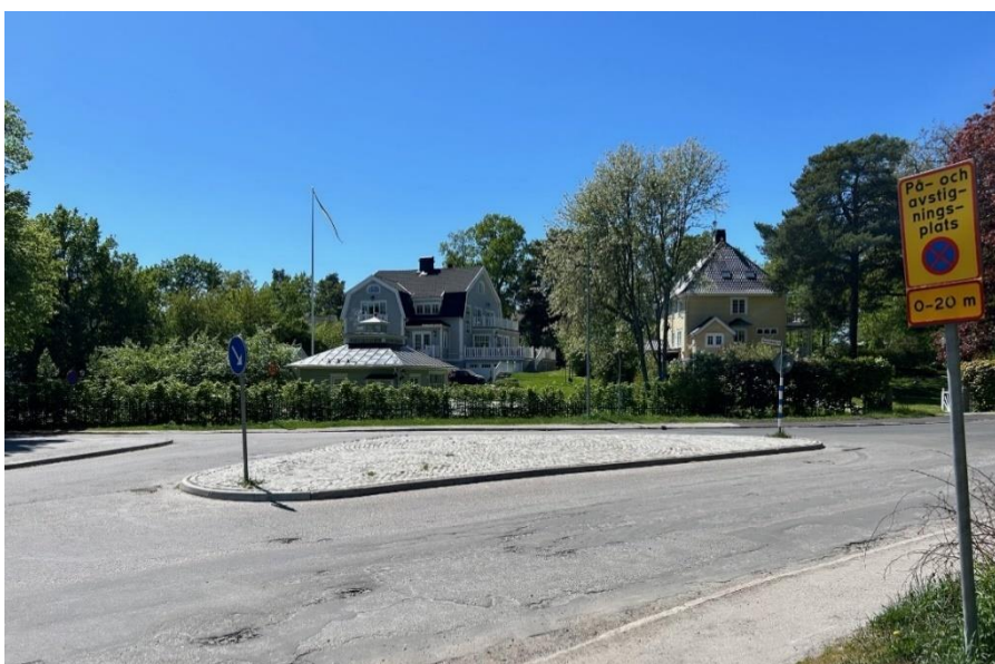
Figur 3 På- och avstigningsplats i cirkulationsplatsen Viktor Rydbergs väg/Sveavägen; sett från skolan. Bild: Tyréns
