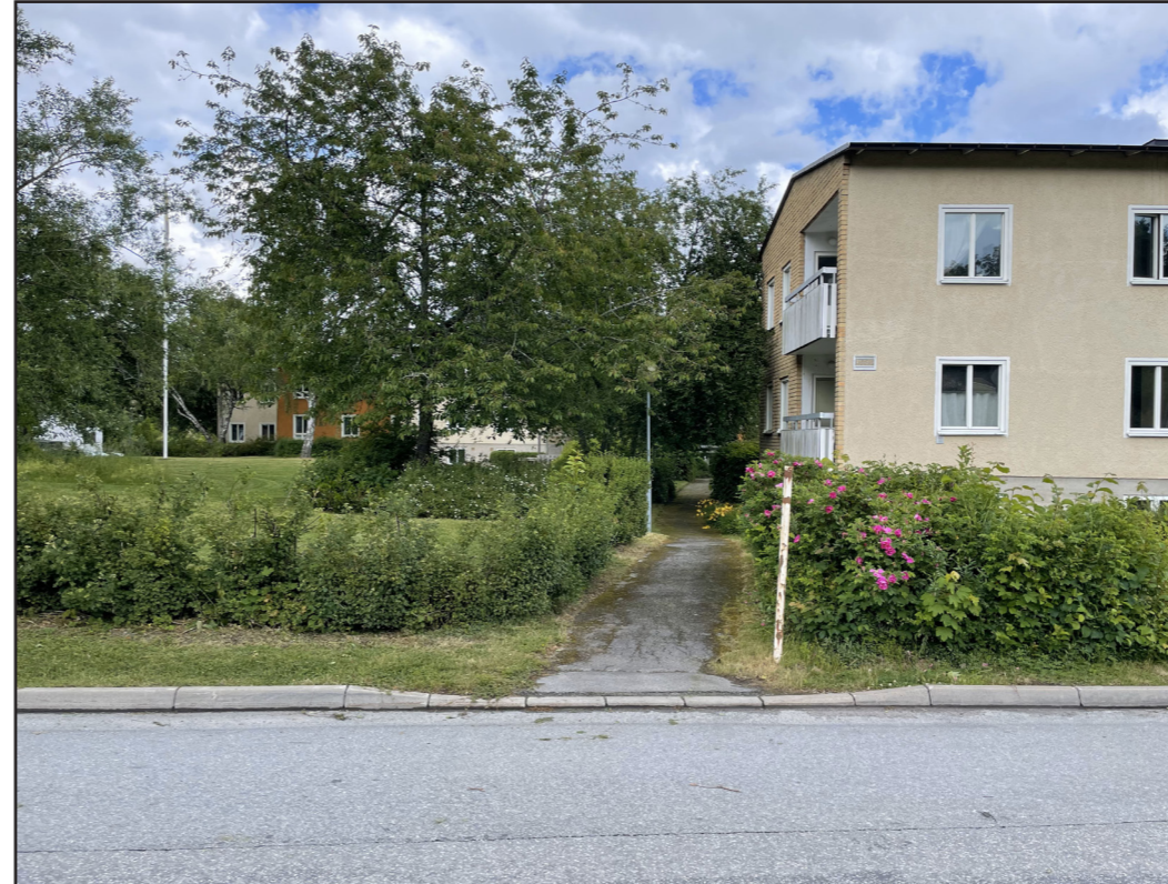
Överst t.v. Från hörnet Johan Banérs gata och Svanholmsvägen. Överst t.h. Vy in i kvarteret från Johan Banérs väg. Befintlig bebyggelse syns tydligt trots sitt mycket indragna läge. Nederst t.v. Fastighetens nordvästra hörn med den karaktärsskapande eken. Nederst t.h. Befintlig bebyggelse är tydligt synlig från Svanholmsvägen.
