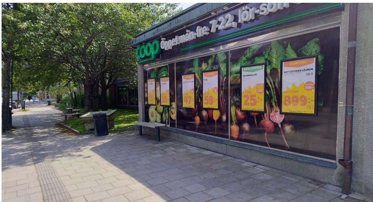
Figur 3-5. Byggnadens norra fasad och ytor.
