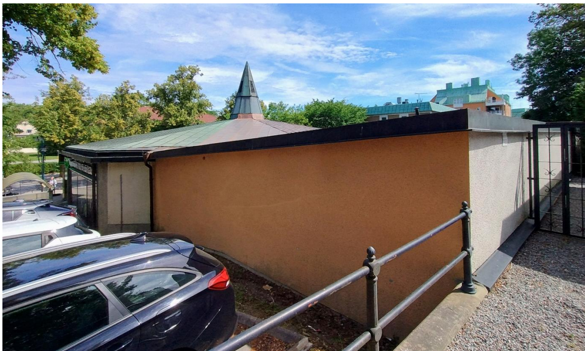
Figur 3-1. Fotografi på fastighetens sydvästra hörn där mur mot fastigheten i söder är synlig. Större delen av fastigheten består av tak.
