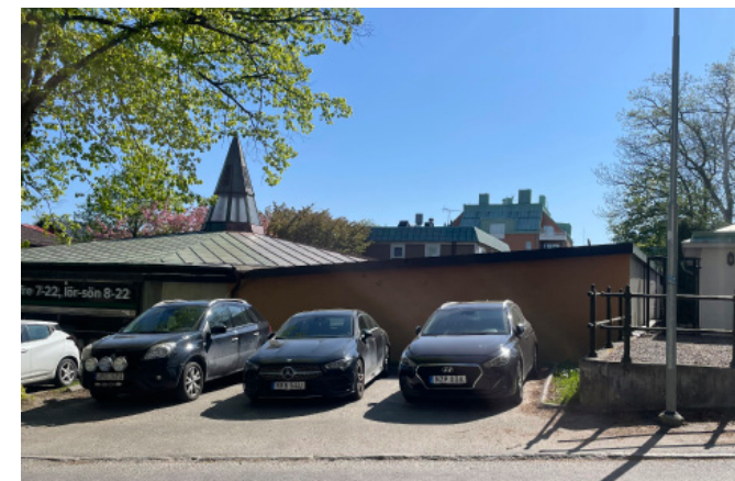
Tillbyggnaden sedd från Auravägen.
