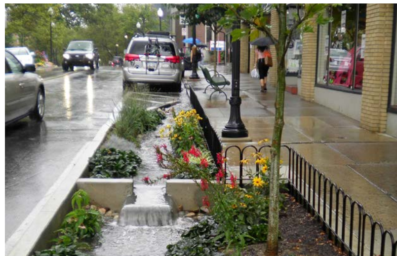
Multifunktionell möbleringszon med angöringsplats, sittplats och grönska. Nedsänkta grönytan med regelbundet planterade träd är en del av dagvattensystem och samtidigt välgörande för gatans mikroklimat. Allen street raingarden
