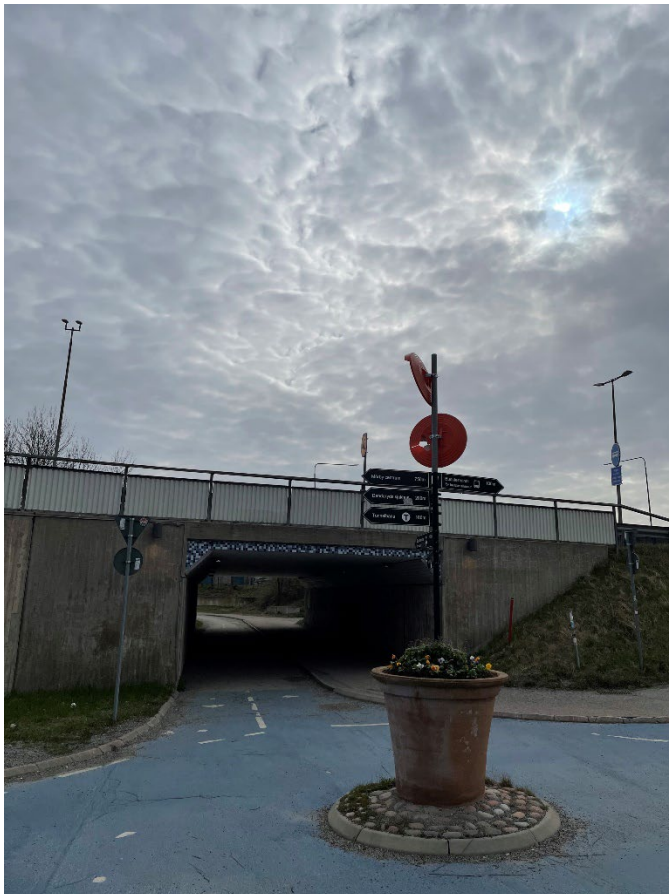
Figur 9. Gång- och cykelkoppling under Mörbygårdsvägen mot Mörby station. Foto Tyréns.
