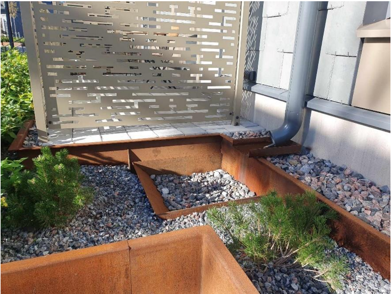
Figur 14. Exempel på utformning av erosionskydd vid utkastare (egen bild).
