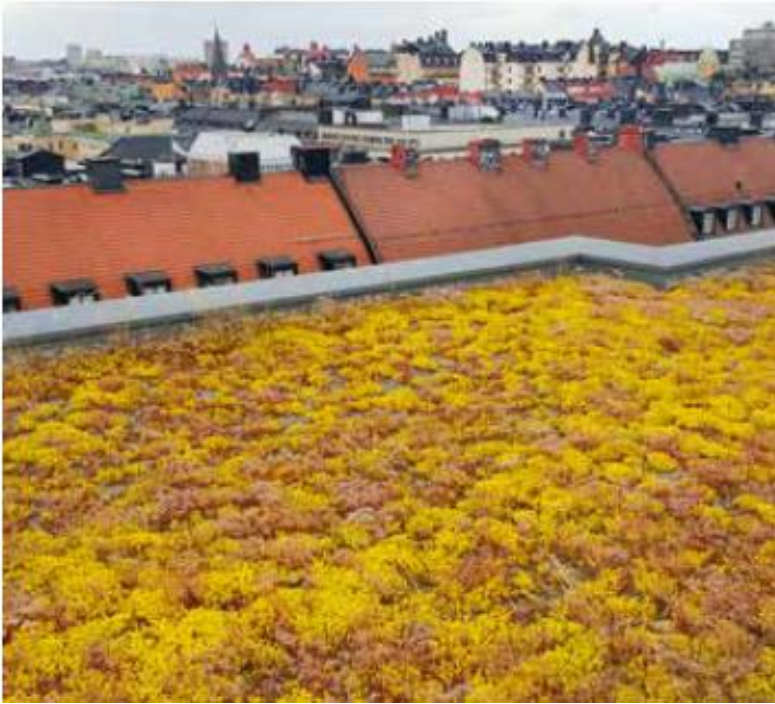
Figur 15. Exempel på sedumtak hämtat från Grönatakhandboken.
