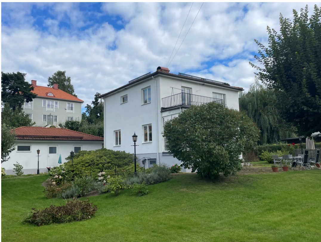
Byggnaden inom fastigheten Nyckelpigan 5. Foto: Danderyds kommun
