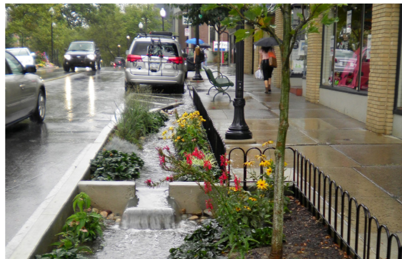
Multifunktionell möbleringszon med angoringsplats, sittplats och grönska. Nedsänkta grönytan med regelbundet planterade träd är en del av dagvattensystem och samtidigt välgörande för gatans mikroklimat. Allen street rainingarden
