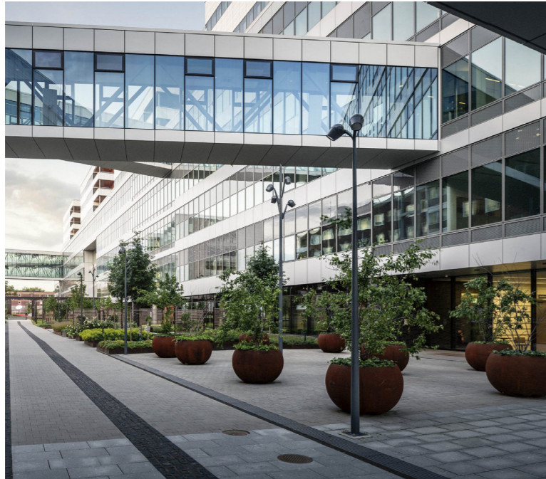
Delad yta med utvidgad möbleringszon som skapar platsbildning. Förbindelsgång med nätt uttryck. Nya Karolinska sjukhuset, Tengbom, foto Feliz Gerlach
