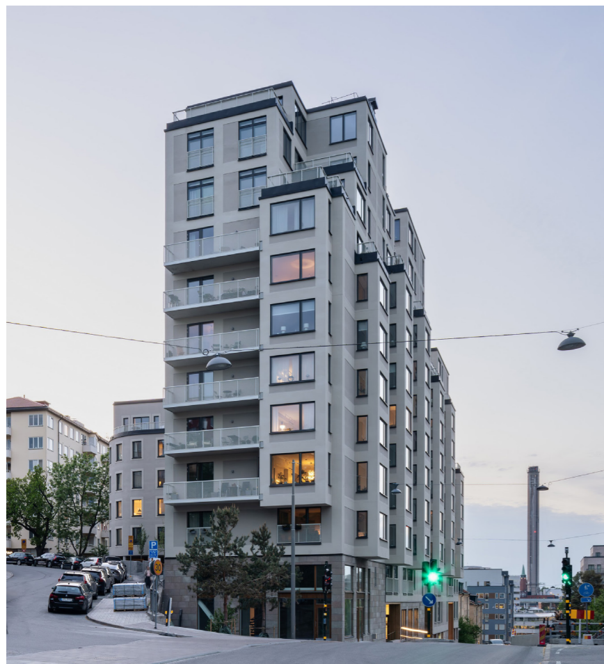
Referensprojekt. Putsad fasad med burspråk och balkonger.
