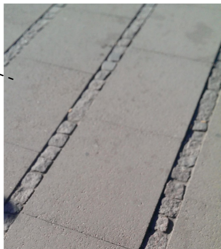
Gatsten i ramp.
