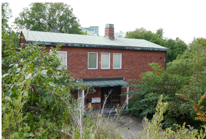
Svärdet 20 med taktäckning och byggnadsdetaljer i koppar.
