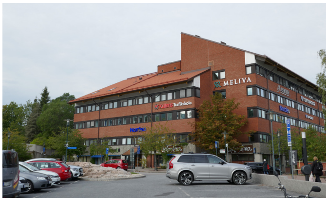
Svärdet 7:s kontorsbyggnad.
