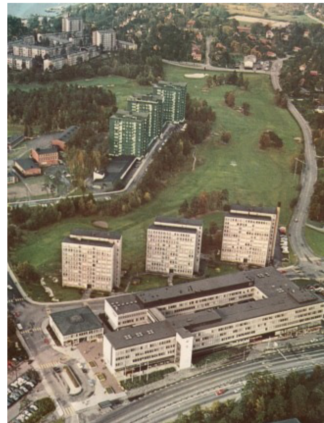
Mörby centrum 1967 innan centrumhuset byggdes om.
