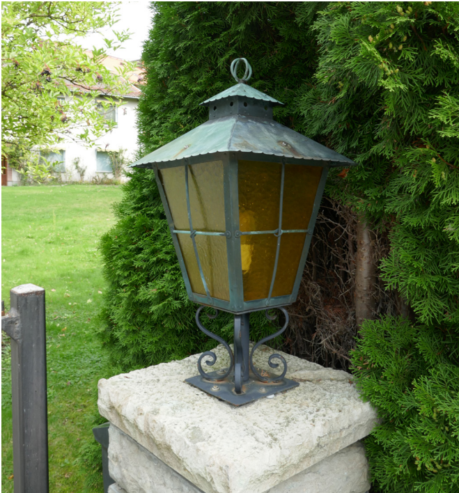
Belysningsarmatur i koppar.
