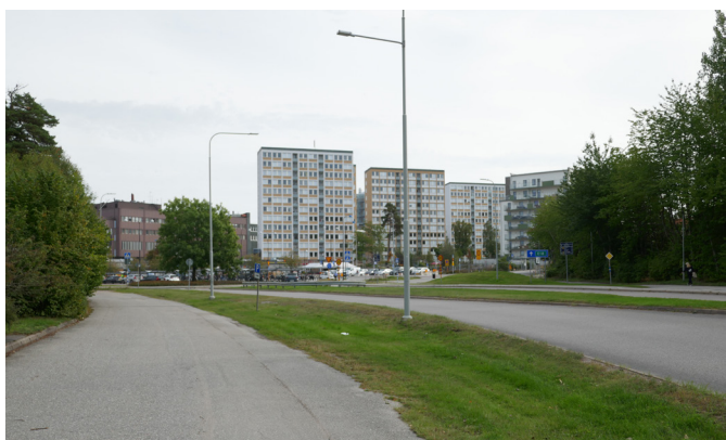
Punkthusen i nio våningar som ansluter till centrumbyggnaden.
