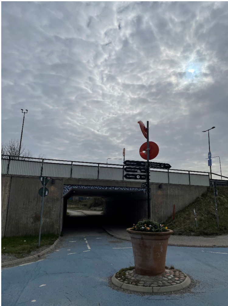
Figur 10. Gång- och cykelkoppling under Mörbygårdsvägen mot Mörby station. Foto Tyréns.
