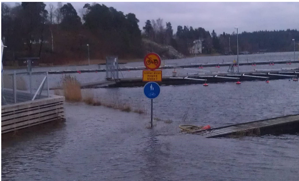
Figur 14, översvämningsskydd vid Nora strand.
