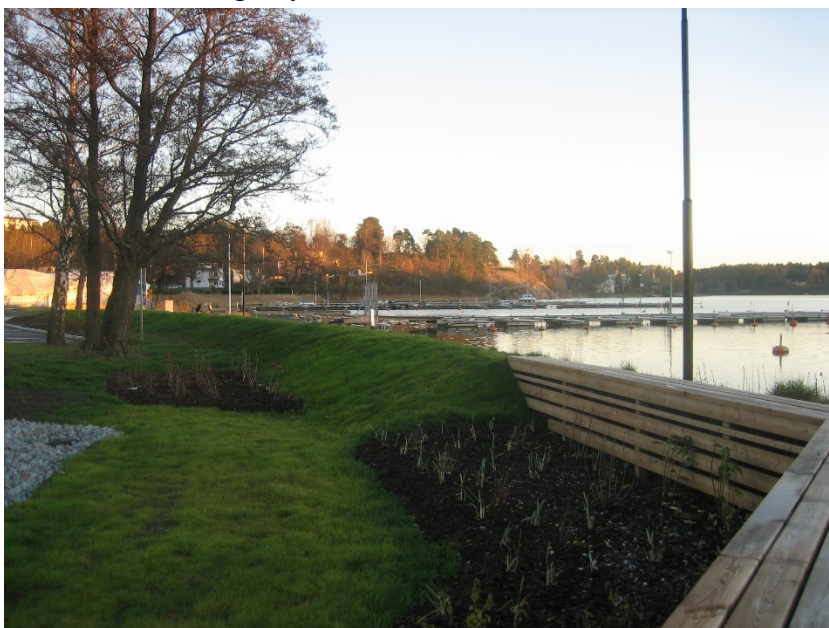
Figur 11 Översvämningsskydd vid Nora strand
