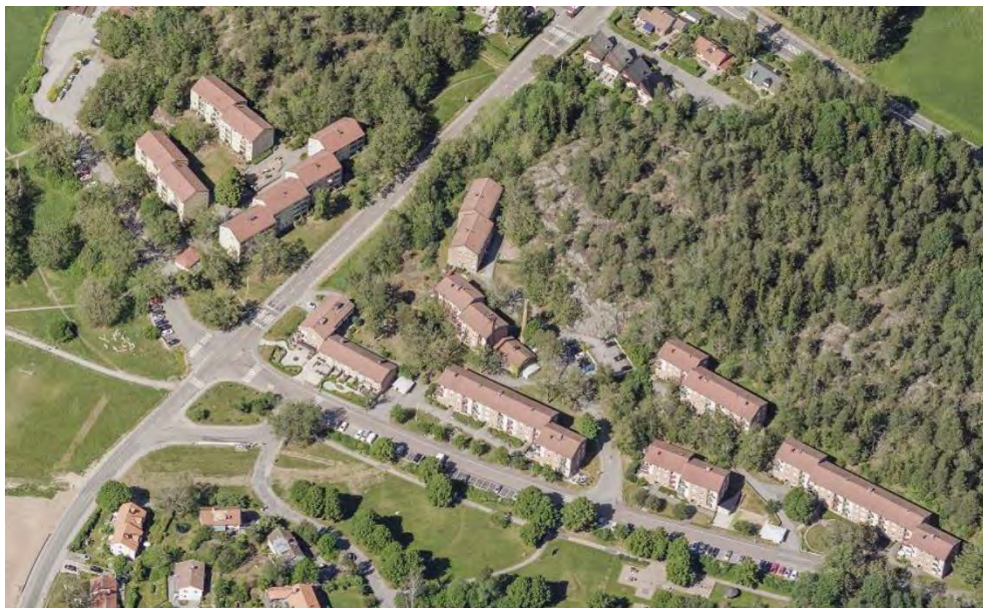
Bild ovan: Sätträängsvägen - Ortofoto från 2019.
