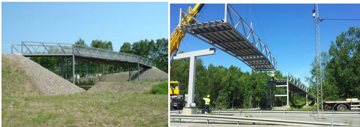
Figure 1 Exempel på fackverksbroar av stål (Bilder: Knislingeverken, Stål och rörmontage Sölvesborg)
