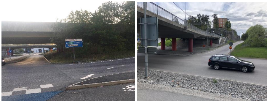
Figur 53 En breddning av körbanan under bron skulle även påverka ramperna till/från E8
