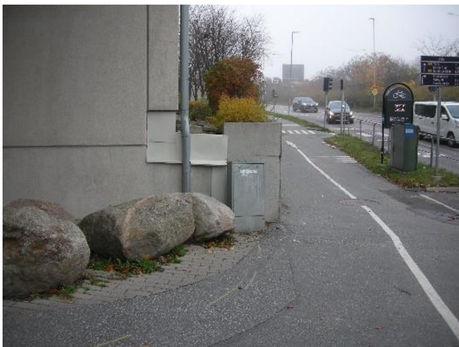
Figur 57 Ett elskåp hamnar i gångbanan när muren rivs och GC-banan breddas
