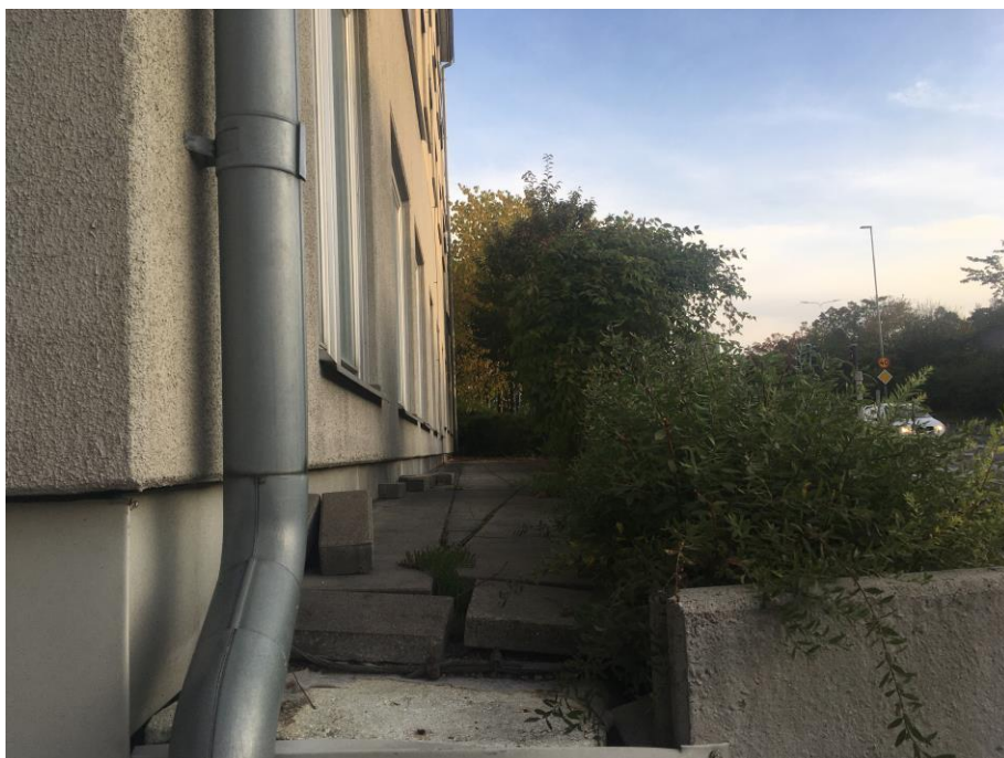
Figur 56 Plattläggningen ovanpå garagetaket
