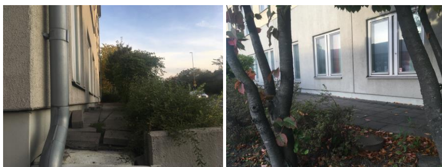
Figur 7 Den del som är på fastigheten är försedd med betongplattor medan planteringen är på kommunens mark
