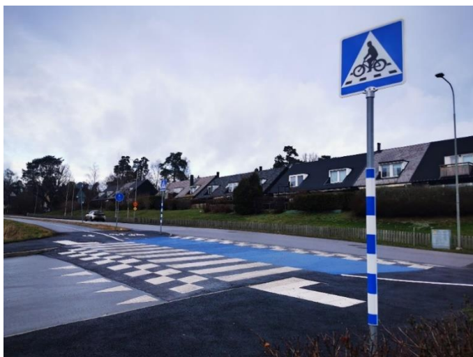
Figur 1: Cykelöverfart i korsningen Danderydsvägen - Östbergavägen
