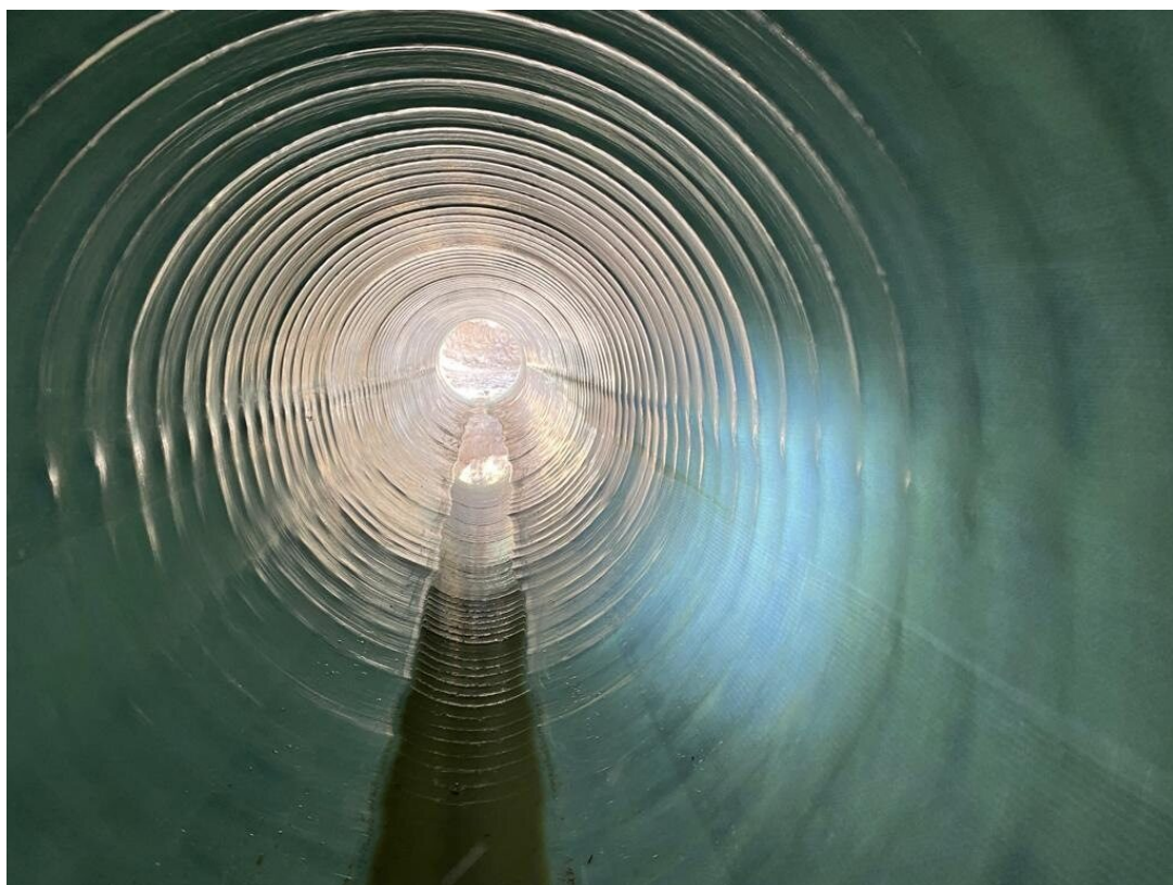
Figur 1, Renoverad dagvattenledning, Nora torg Fotograf: Simon Åkerlund
