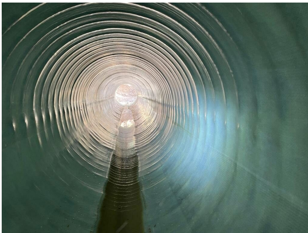
Figur 1, Renoverad dagvattenledning, Nora torg Fotograf: Simon Åkerlund
