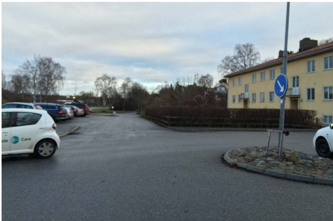
Befintlig parkeringsyta och byggnad inom Hornet 1
