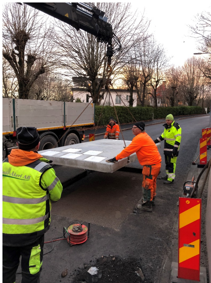
Bild från anläggandet av busskudde utmed Långängsvägen.
