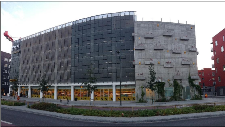
Figur 5-4 Parkeringshus i kv. Fullriggaren i Malmö där parkering har kombinerats med en matbutik i bottenvåningen. Källa: www.pmalmo.se
