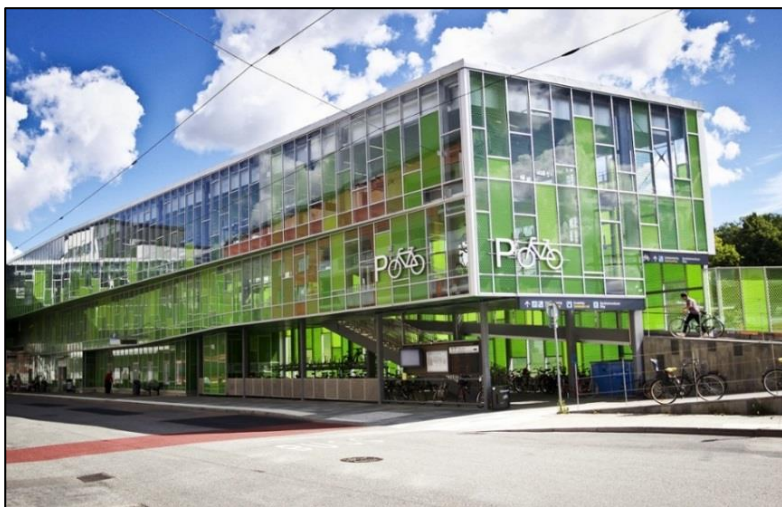
Figur 5-3 Cykelgaraget vid pendeltågstation i Älvsjö på tre plan. Bild: https://mitti.se
