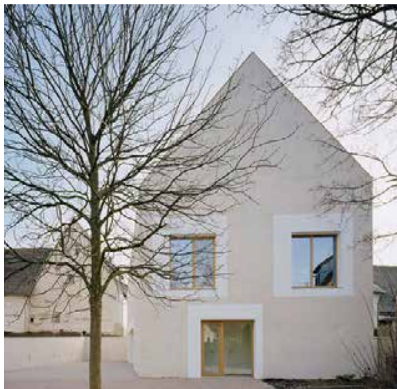
PUTS FASAD INRAMNING AV DÖRRÖPPNINGAR OCH FÖNSTREN
