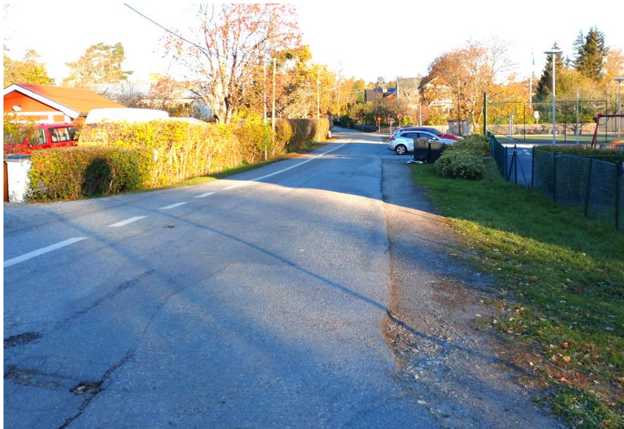
Bild 6 Den uppkörda gräskanten längs med Västerångsvägen visar på att många kör sina fordon vid sidan av vägen. Den målade gångbanan syns till vänster i bild.
