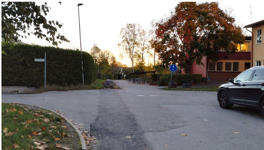
Bild 3 Tillåten parkering ända fram till vändplatsen gör det inte möjligt att vända runt utan backningsrörelse.
